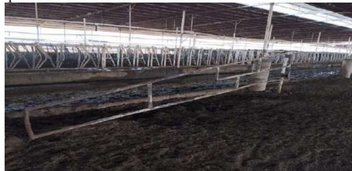
Figura 2. La puerta de las instalaciones debería tener dimensiones recomendadas de 1.5 x 4 metros para facilitar el paso de tractores, y los postes deberían estar firmemente colocados para garantizar su resistencia (Ortiz et al., 2005). Sin embargo, en esta evaluación se constató que los postes actuales no ofrecen suficiente soporte para contener al ganado de manera segura.
