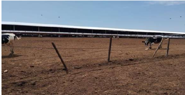
Figura 1. Las cercas divisorias entre los corrales presentan malas condiciones debido al tensado excesivo del tejido y el empuje constante del ganado. Se observó que no cumplen con las recomendaciones establecidas en el Manual de Buenas Prácticas Pecuarias de SENASICA (2019), que especifica una separación de 45 cm entre los hilos horizontales.
